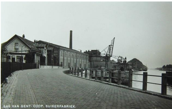
75. Rechts: Sas van Gent – Gebouw huidige Dockside (links in beeld) en Coöperatieve Suikerfabriek – ansichtkaart 1955
